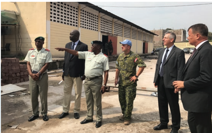
Le chef de la division RSS entame une visite du chantier du CHESD, le Collège des Hautes Etudes de Stratégie et de Défense des FARDC (mai 2017)
